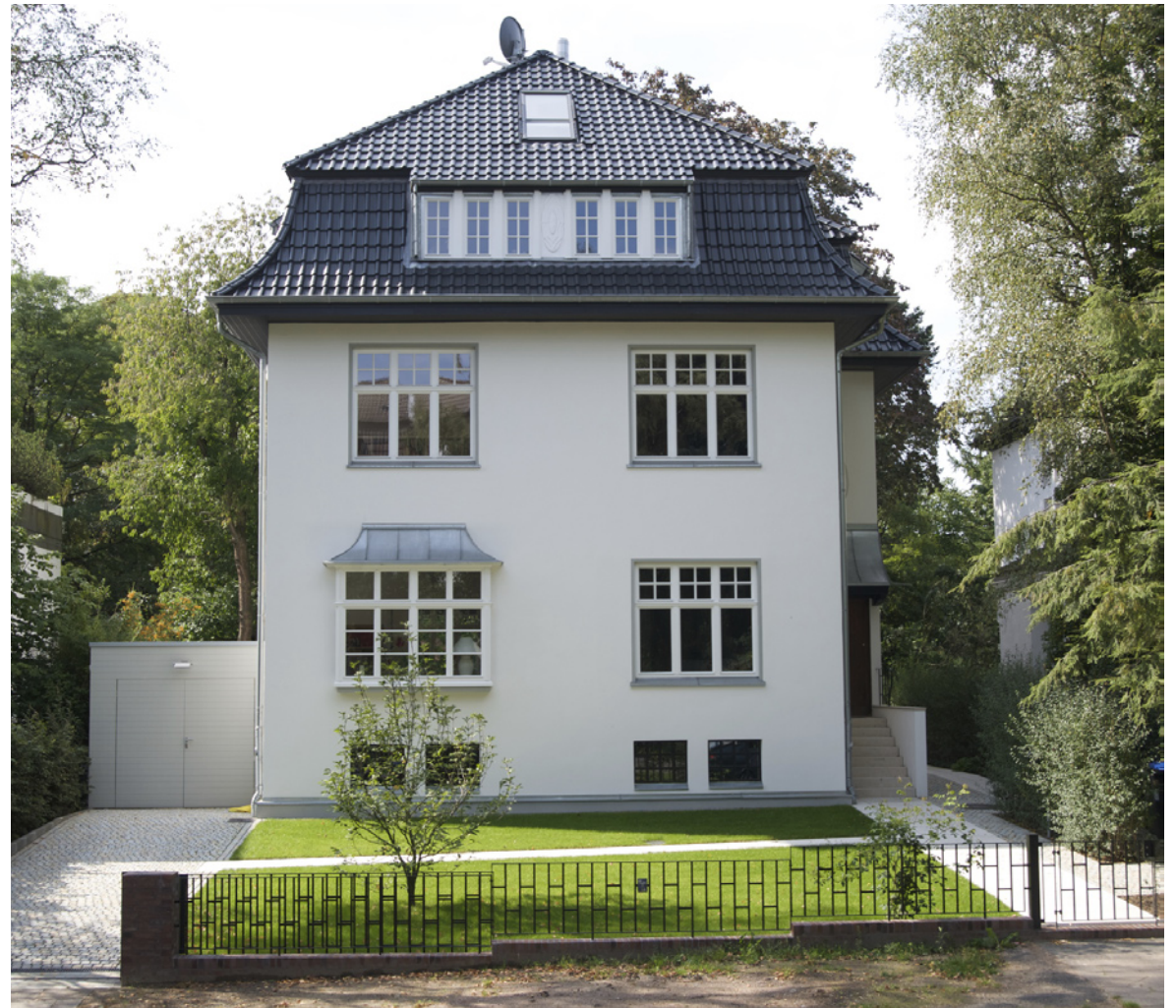
Strassenansicht nach Sanierung und Umbau
