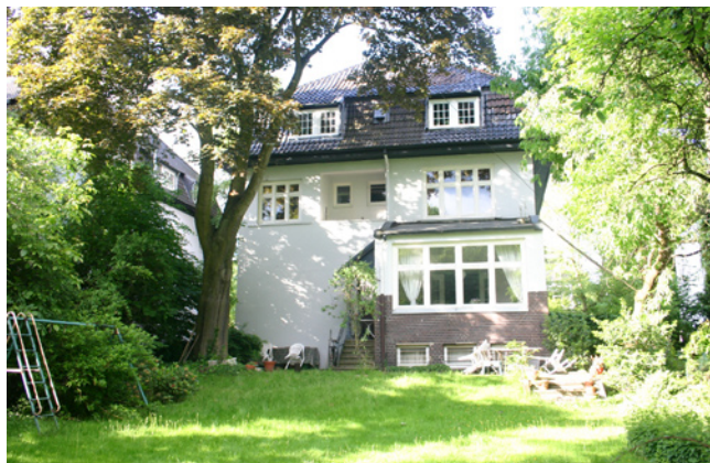
Gartenansicht vor Umbau
