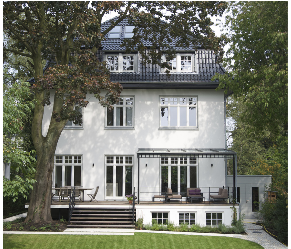
Gartenansicht nach Sanierung und Umbau
