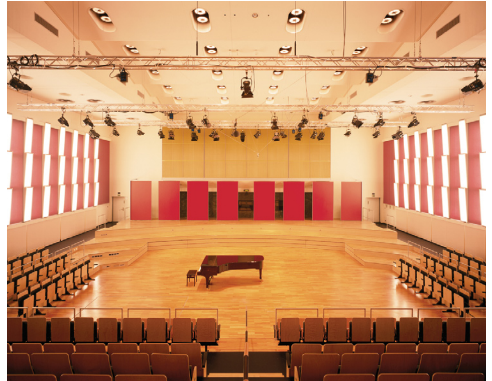
Bühnenraum mit integrierten mobilen Akkustikelementen
