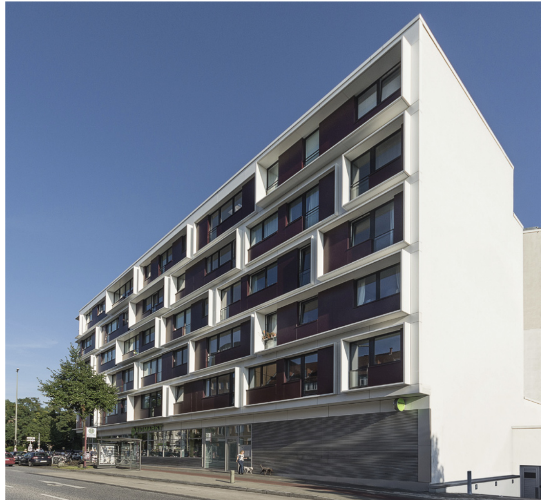
Ansicht von der Altonaer Strasse
