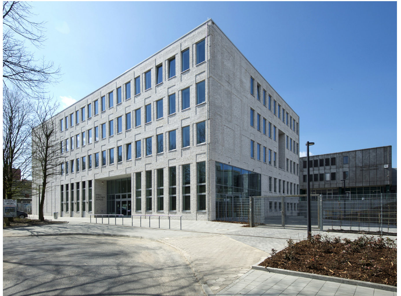
Ansicht mit Haupteingang am Wendehammer
