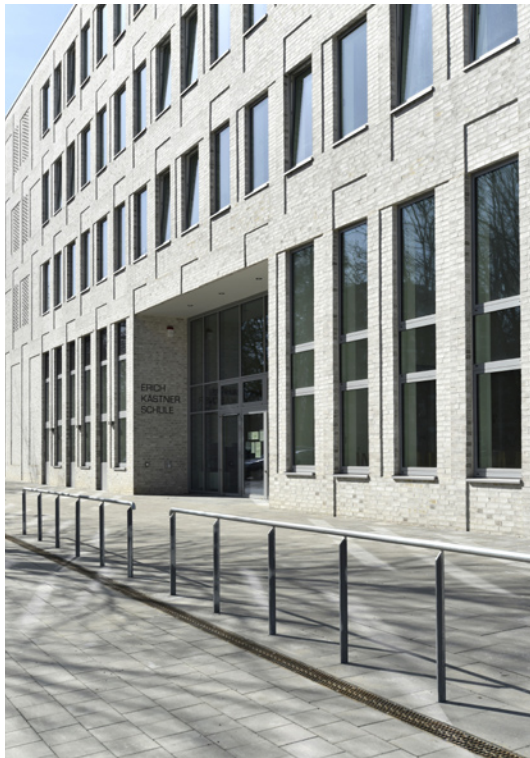
Fassade mit Eingang
