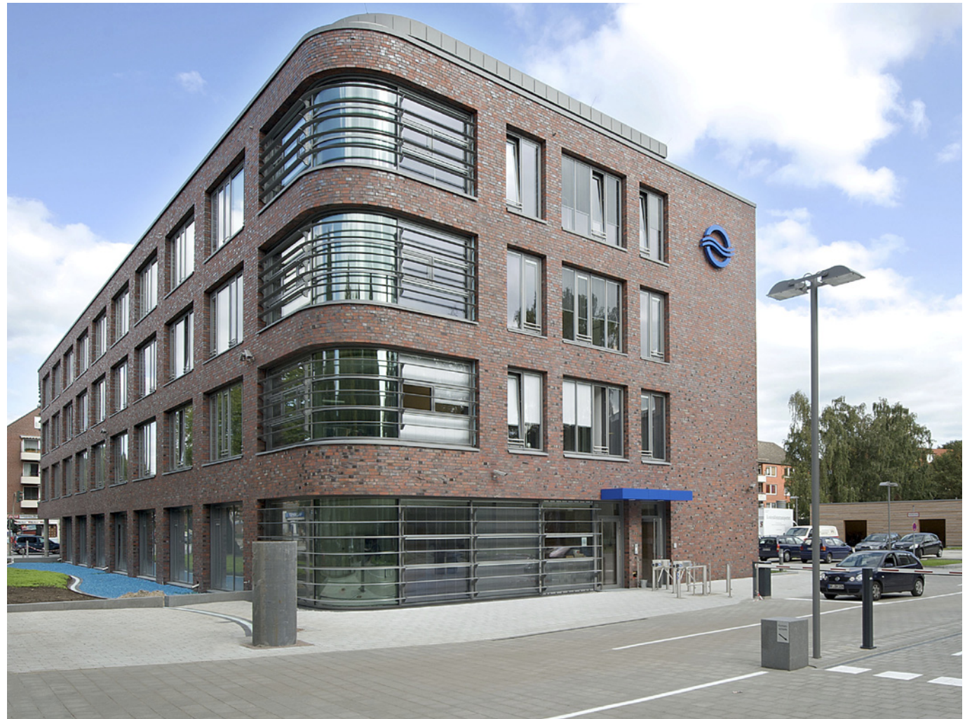
Ansicht Bauteil 1 vom Südkanal
